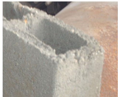
Detalhe 01: Ampliação da Figura 25
