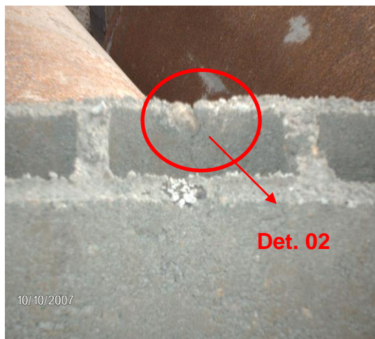
Figura 27: Fissuras
